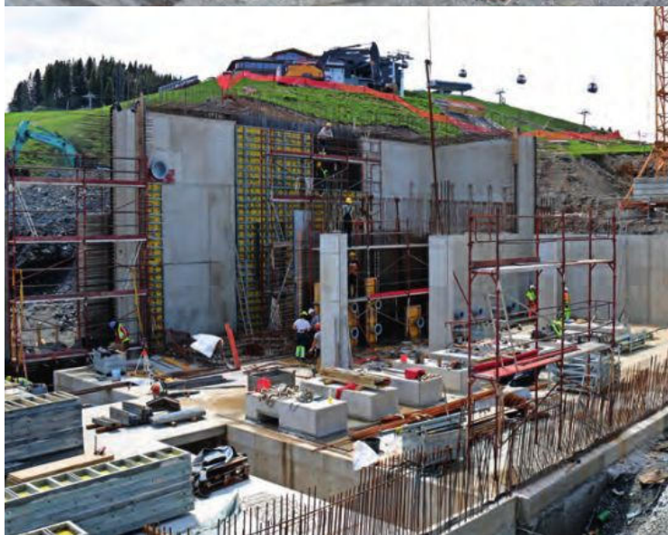
Die neue Pumpstation wird im Damm des Speicherteichs Hartkaiser integriert und ist auch mit einer Kühlturmanlage ausgestattet (Aufnahmen von Anfang Juni 2022).
