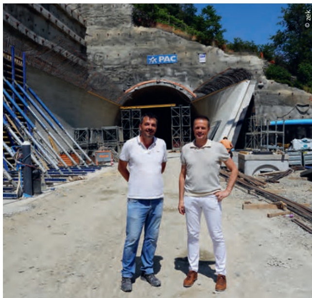
Baustellenbesichtigung im Sommer 2025: Nicola Conci (De.Co.Bau) (li.) und Projektleiter Augustin Hueber (Tiefbauabteilung Provinz Bozen) (re.)
