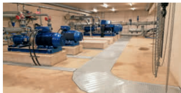
Innenaufnahme der Pumpstation Franzlalm mit den derzeit installierten vier Hauptpumpen, im Endausbau sollen noch zwei weitere hinzukommen. Dann wird die neue Beschneigungsanlage über eine Wasserleistung von 330 l/s verfügen.
