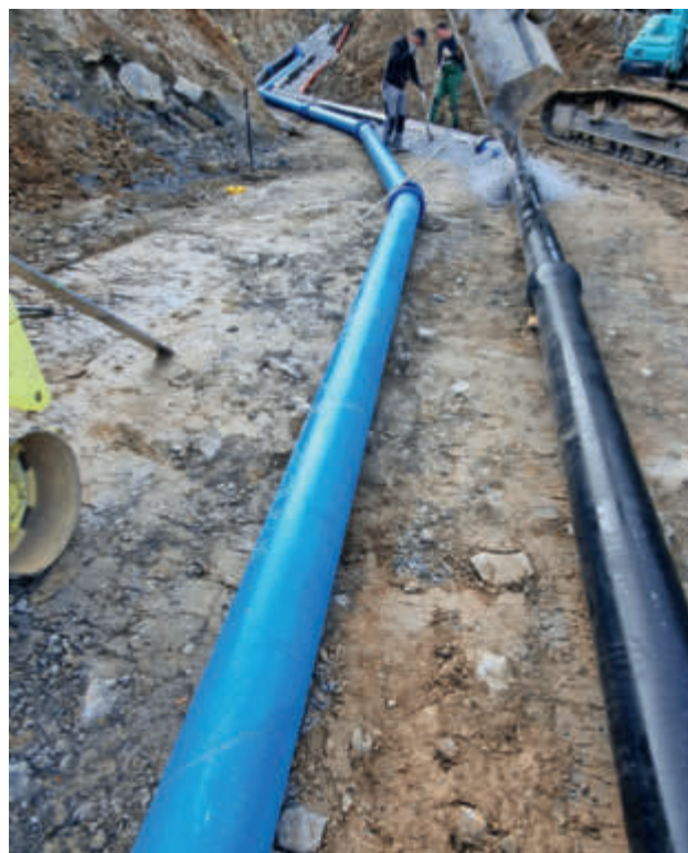
Dank des patentierten VRS®-T-Verbindungssystems mit der Riegelgarnitur sind TRM-Rohre einfach und rasch zu verlegen.
