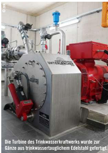
Das Trinkwasserkraftwerk ist seit September in Betrieb und erzeugt im Jahr rund 800.000 kWh Strom.
