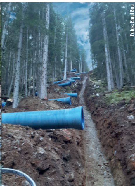
Im steilsten Geländeabschnitt wurden die Rohre per Heli angeliefert und entlang der Künette verteilt.
