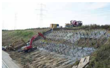
Stabilizzazione dei pendii
