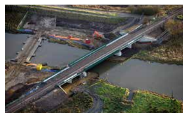
Costruzione di ponti
