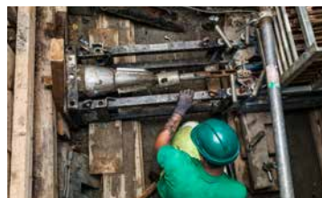
Metodo di posa senza scavo
