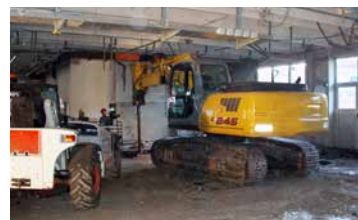
Rinforzo fondazioni con altezza di lavoro limitata
