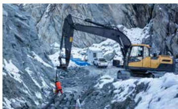
Condotte per innevamento e alta pressione
