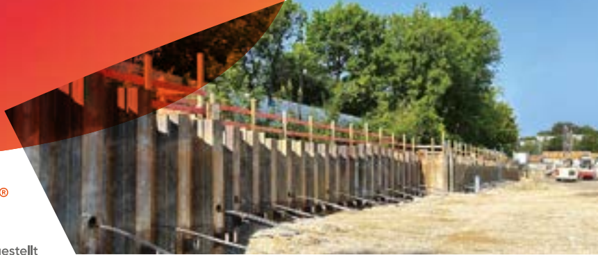
Nachhaltige Baugrube RS76, München (DE), © Züblin Spezialtiefbau
