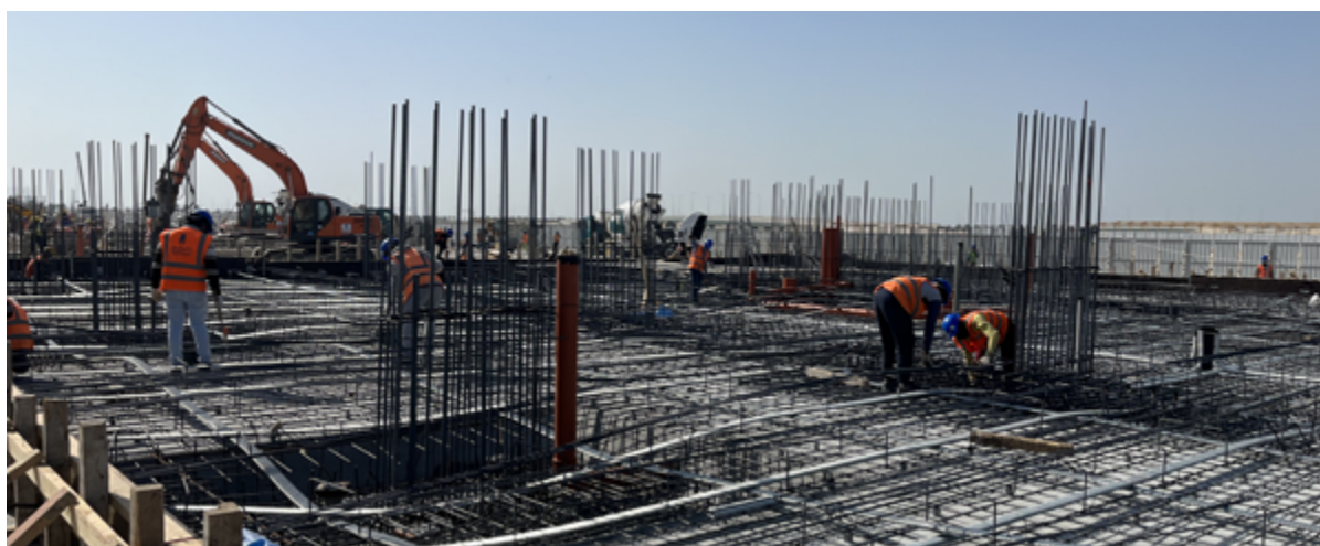
Bewehrung der KPP
