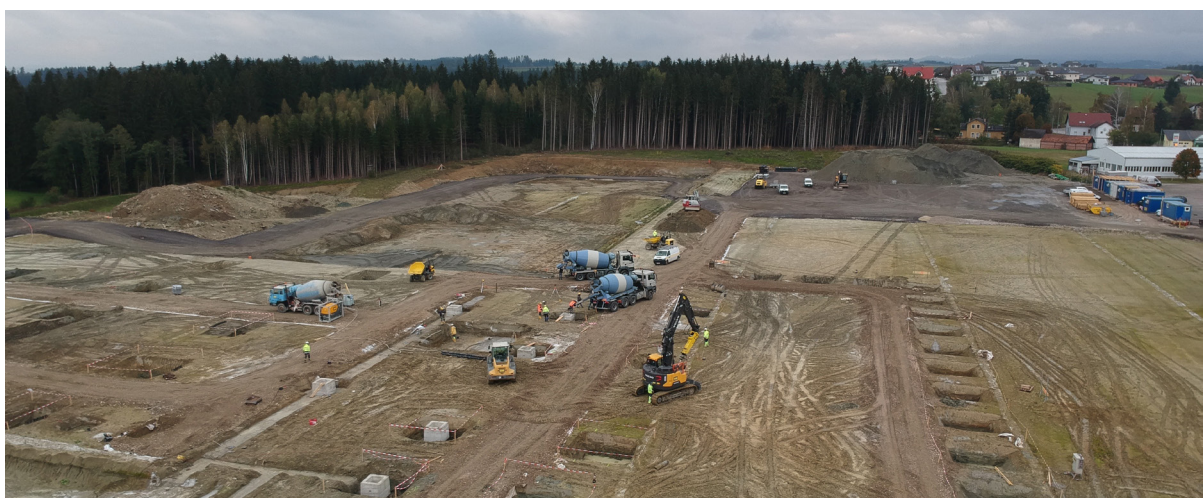
Eine große Baustelle, auf der die schnelle Installation des TRM-Pfahlsystems voll genutzt wurde.
