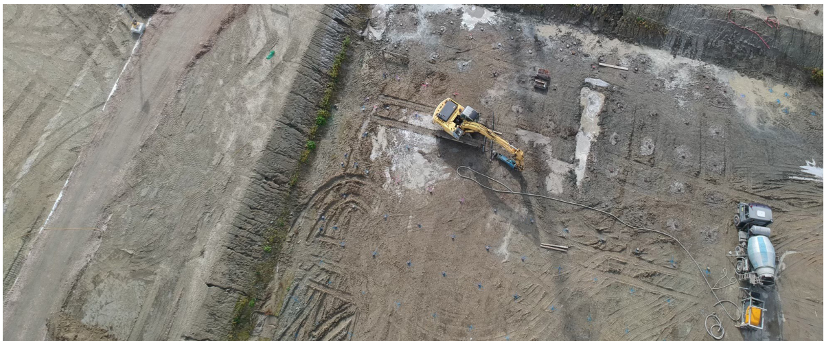
Installierte Pfähle, der Bagger ist bereit für die Arbeit
