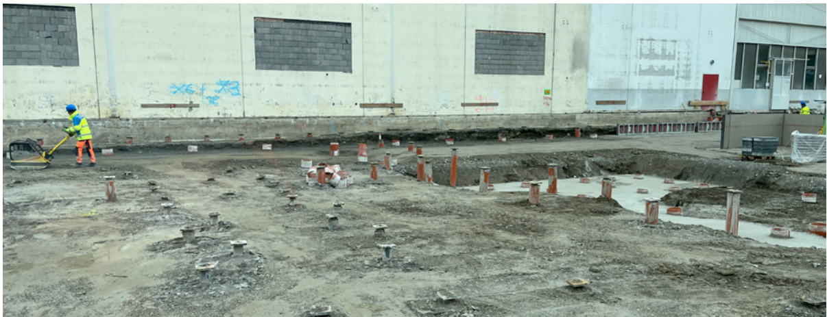
Gründung aus TRM Duktillrammpfählen
