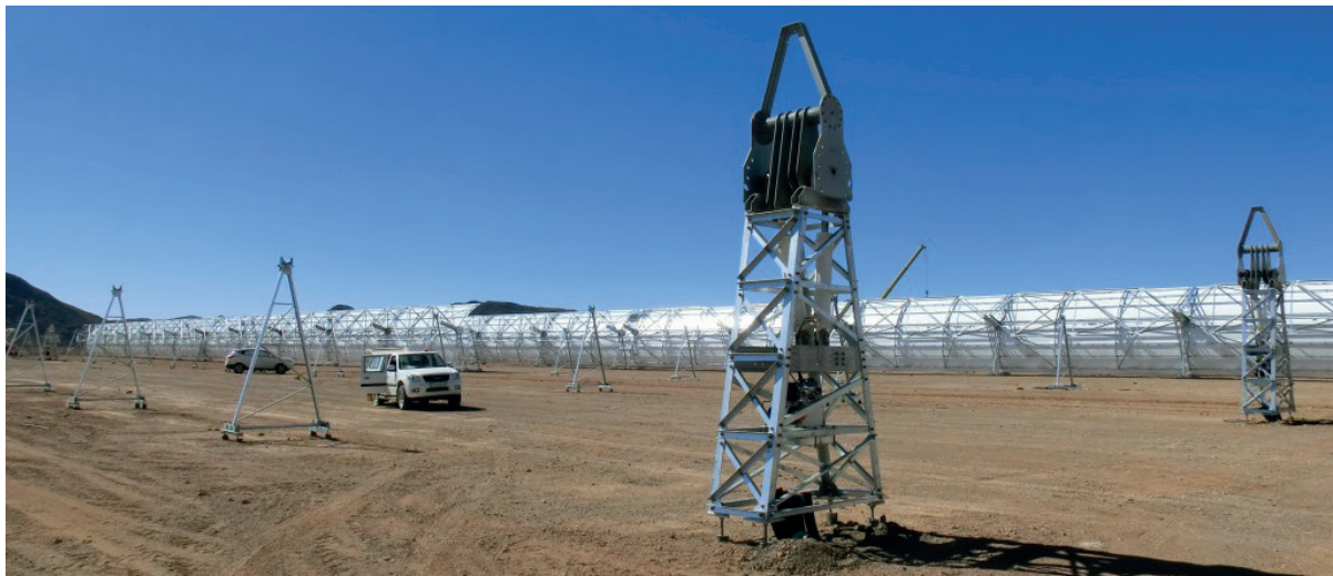
Vorbereitung für die Montage der Parabolspiegel
