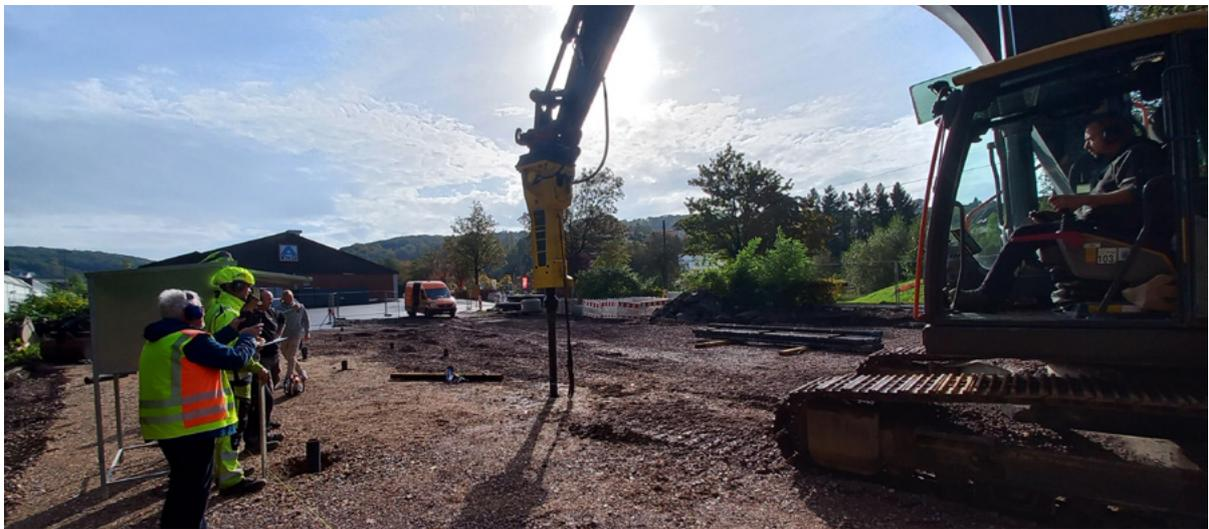
Pfahleinbringung unverpresster TRM Duktillrammpfähle in Anwesenheit des Tragwerkplaners
