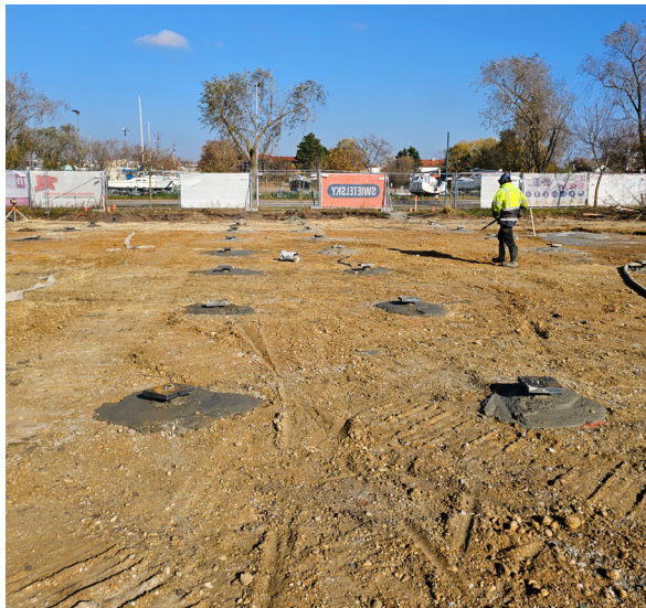
Baugrundsituation im Projektbereich Neusiedl
