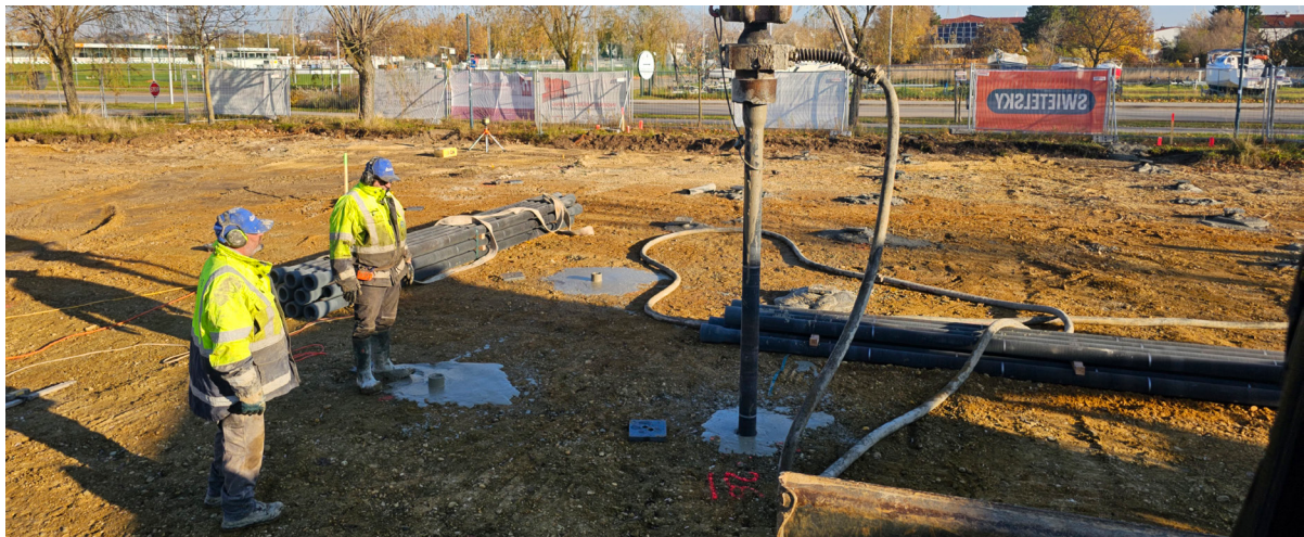
Einbringen duktiler Gussrampfpfähle
