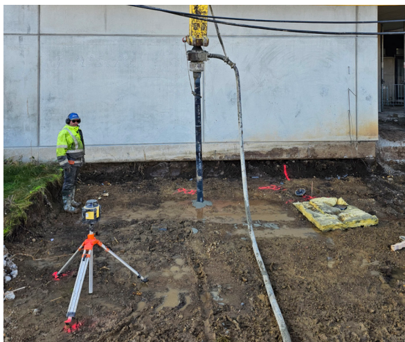
Tiefgründungsarbeiten im Bestand Hallenbad Neusiedl
