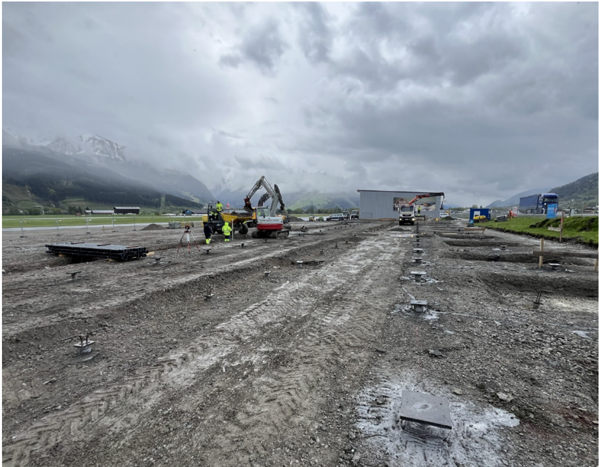
Gründung mit dem TRM Pfahlsystemen
