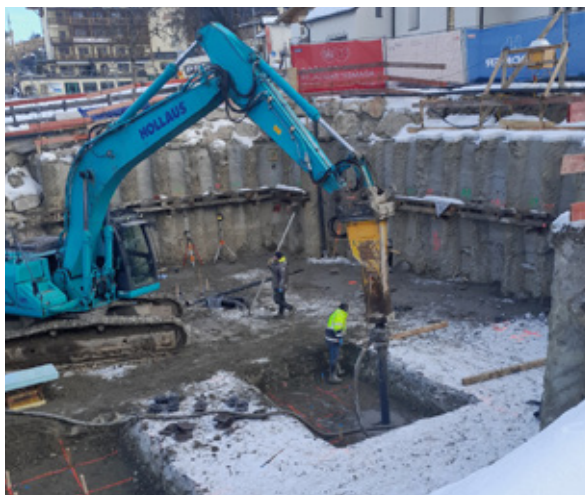
Gründung der Einzelfundamente nach Voraushub
