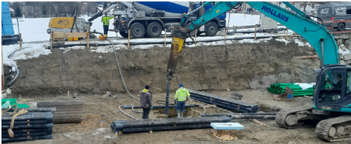
Tiefgründung mittels Duktilrammpfählen
