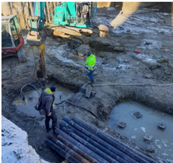
Schwierige Bodenverhältnisse mit Wechsellagen
