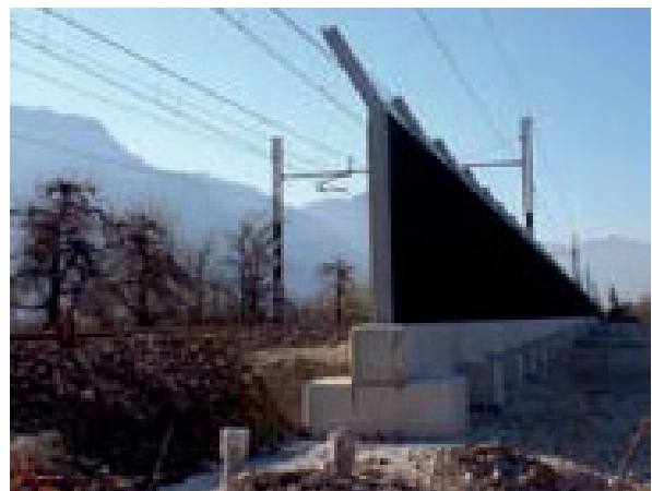
Stützmauer als Unterbau für die Lärmschutzelemente
