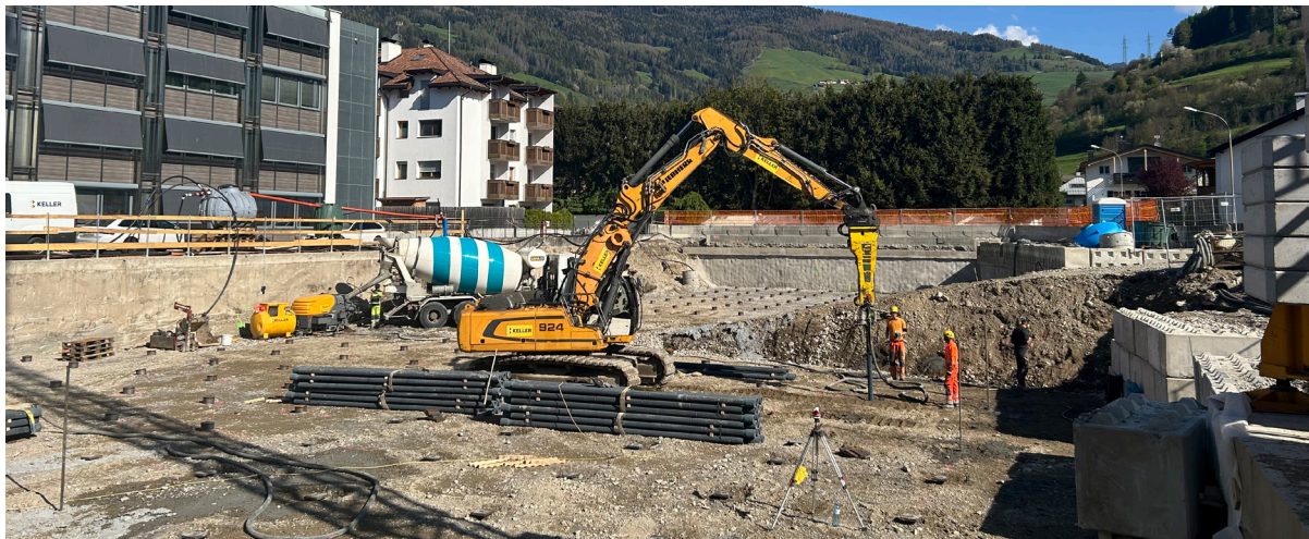
Einbau der TRM-Rammpfähle für das Bürogebäude
