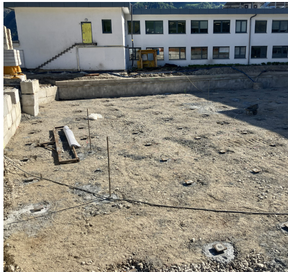
Baugrund am Standort Sterzing
