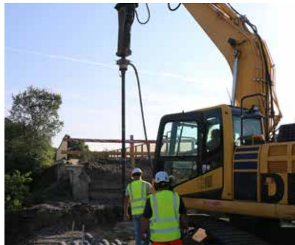
Einbau des TRM Duktirammpfahls
