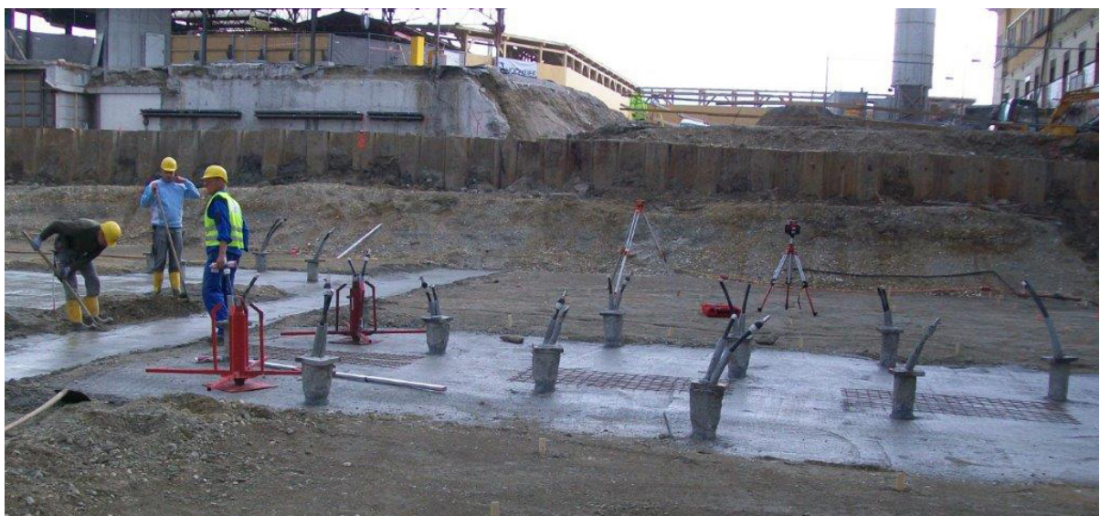
Baufeld mit installierten Duktirammpfählen und enercret®-System
