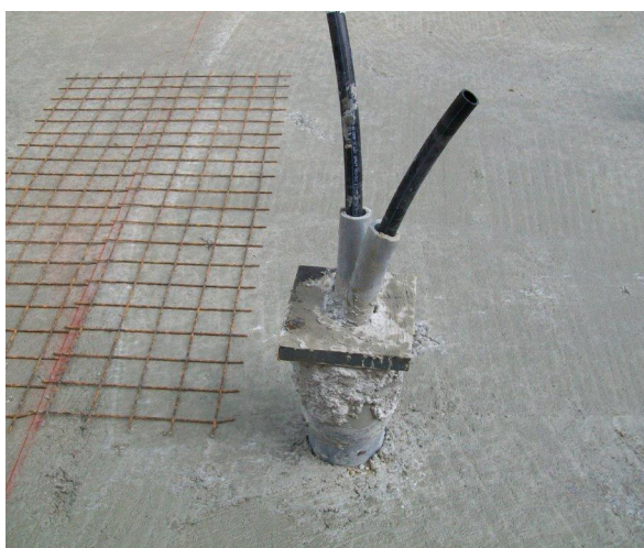
TRM Duktirammpfahl mit den Absorberleitungen
