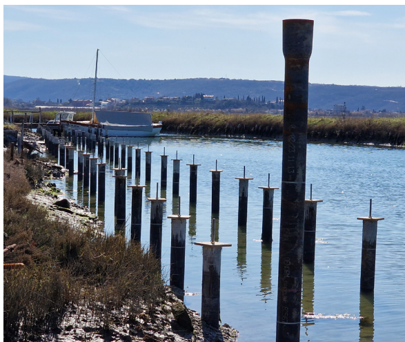
Pfähle für den Holzsteg
