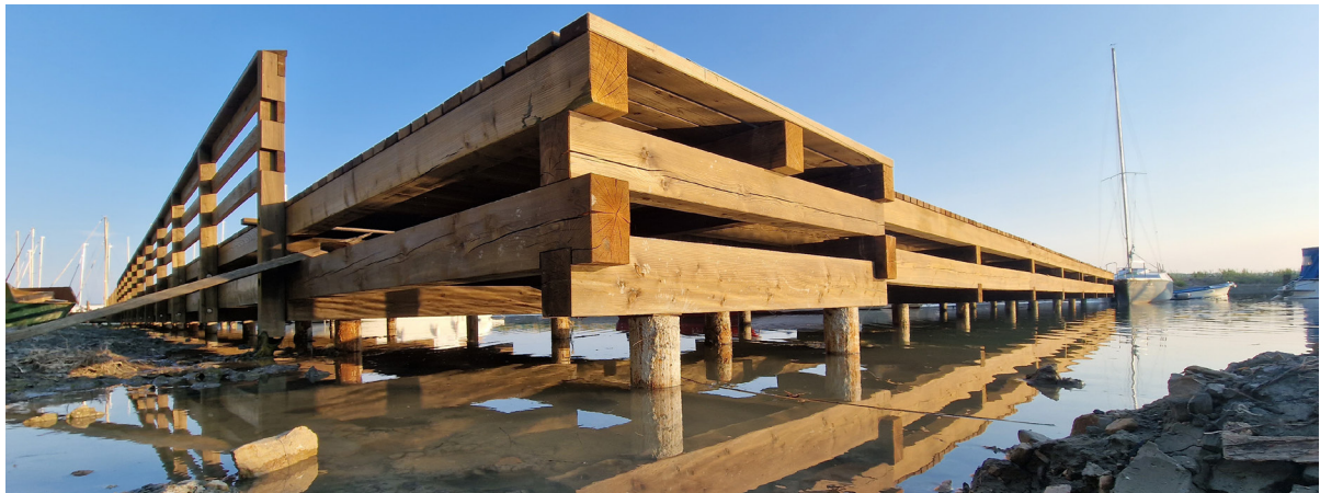
Fertiger Holzsteg auf Duktirammpfählen
