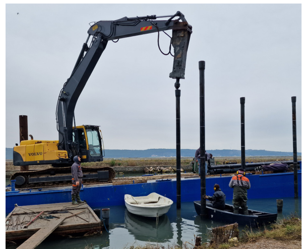
Installation der Pfähle mit Bagger auf Lastschiff
