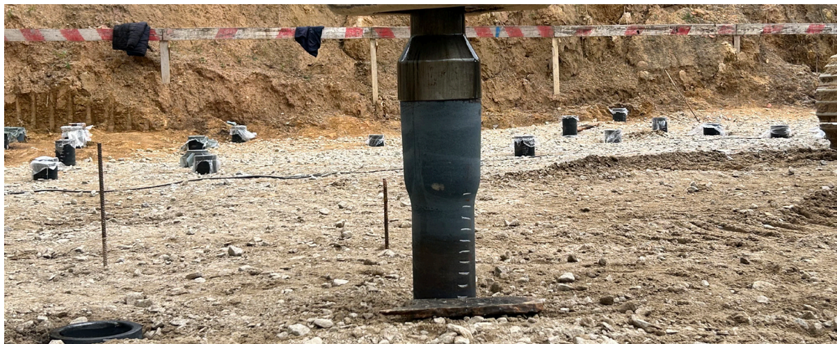
Einbringen der duktilen Gussrammpfähle bis in tragfähige Bodenschichten (ca. 8 m Tiefe)
