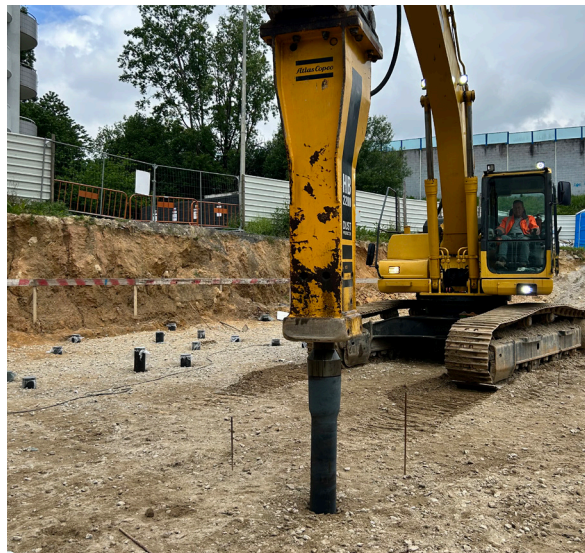
Einsatz eines Hydraulikbaggers
