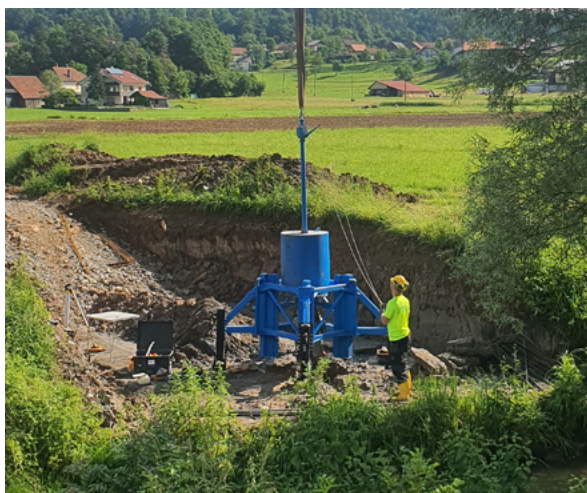
Vorbereitung für dynamische Pfahlprobelastungen
