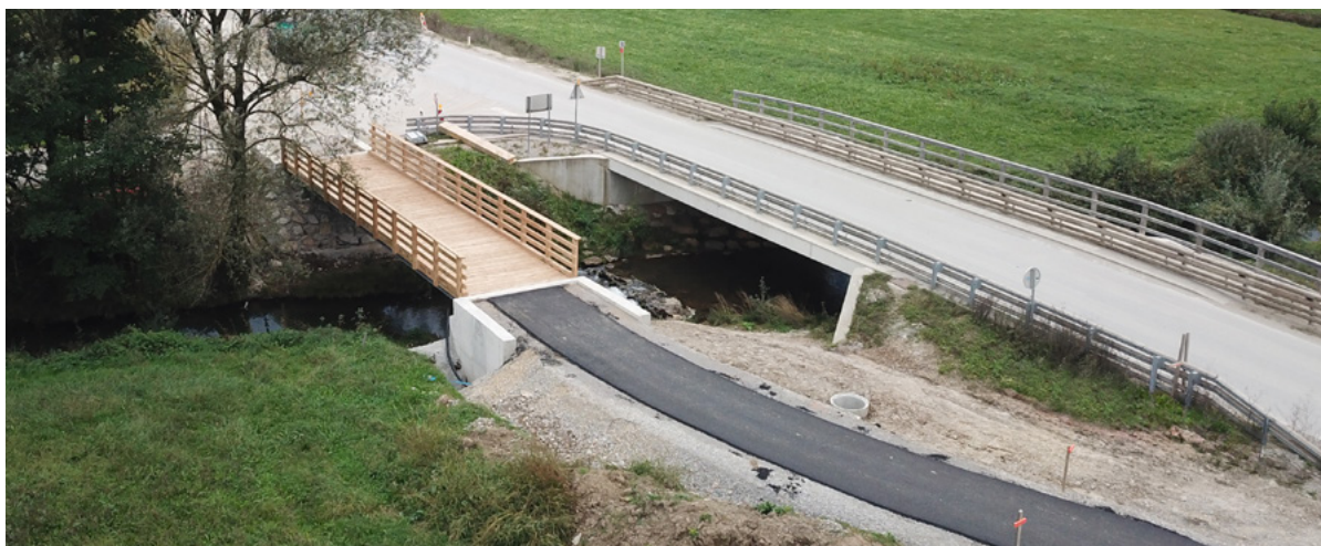
Fertige Stahl-/Holzbrücke auf unverpressten TRM Pfählen
