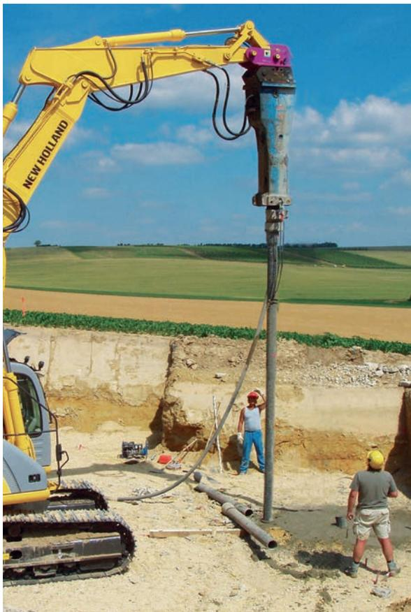
Rammvorgang der mantelverpressten Duktirammpfähle
