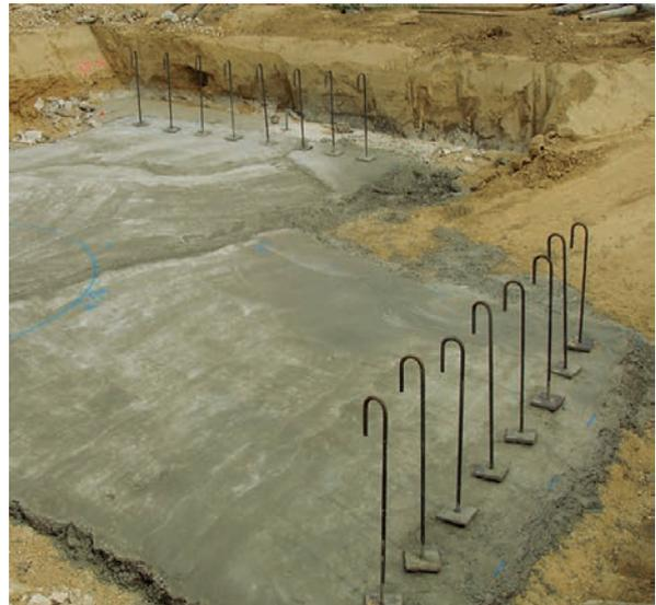
Sauberkeitsschicht mit Anschluss der Zugbewehrung zum Fundament
