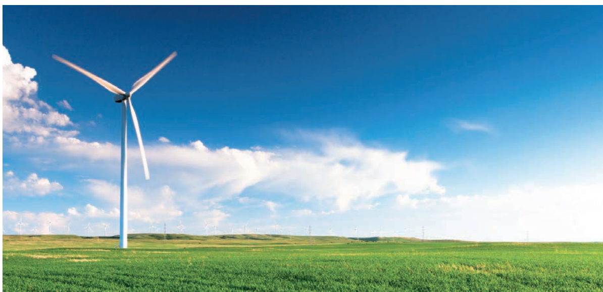
Windkraftanlagen werden auf TRM Duktilrammpfählen gegründet.
