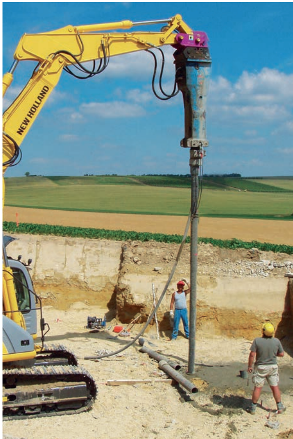
Rammvorgang der mantelverpressten Duktirammpfähle
