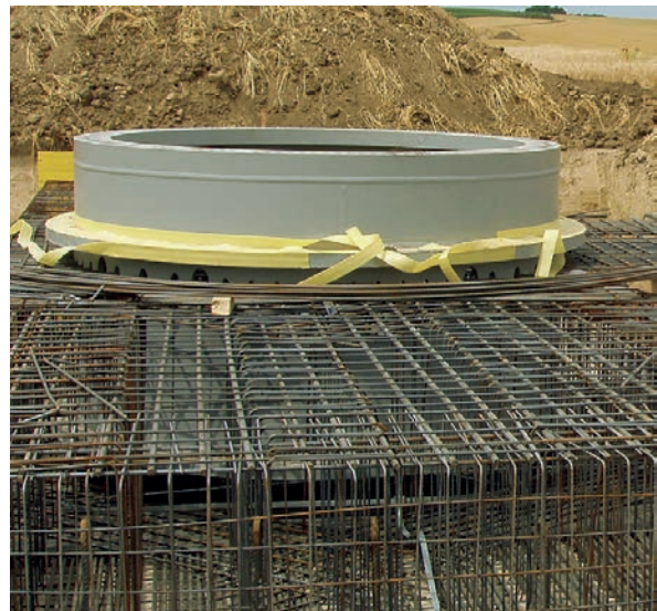
Bewehrung des Fundaments
