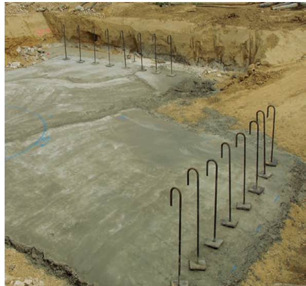
Sauberkeitsschicht mit Anschluss der Zugbewehrung zum Fundament
