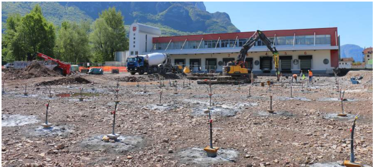
Baufeld mit installierten Pfählen - mit Erdwärmesonden
