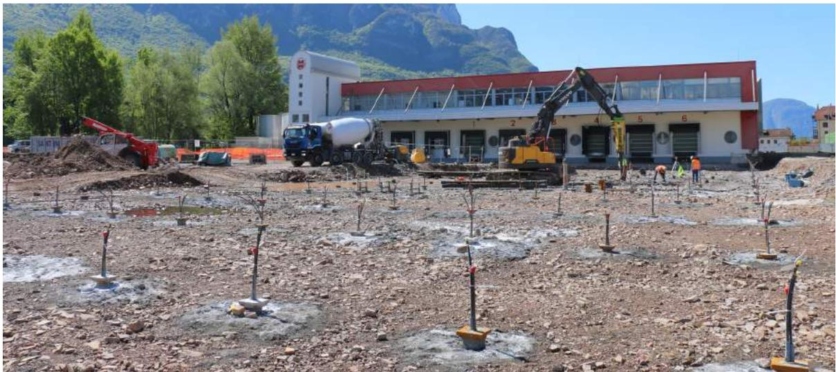
Baufeld mit installierten Pfählen - mit Erdwärmesonden
