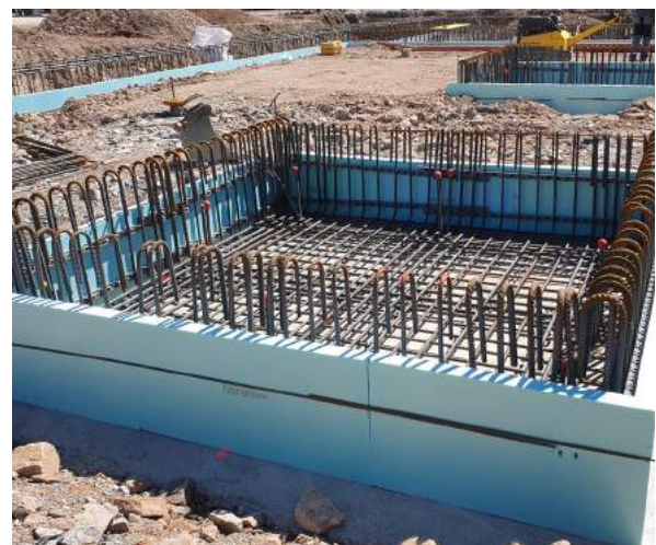
Bewehrtes Fundament
