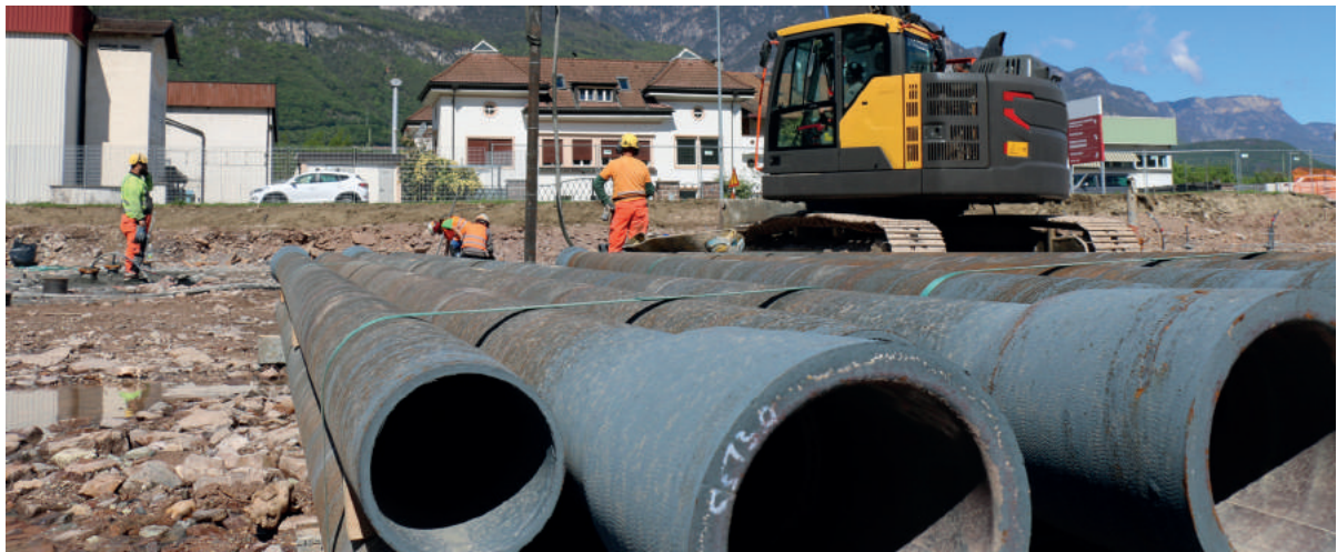
Komplettes Bauwerk steht auf TRM-Pfählen.
