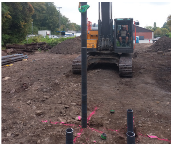
Pfahleinbringung unverpresster TRM Duktillrammpfähle
