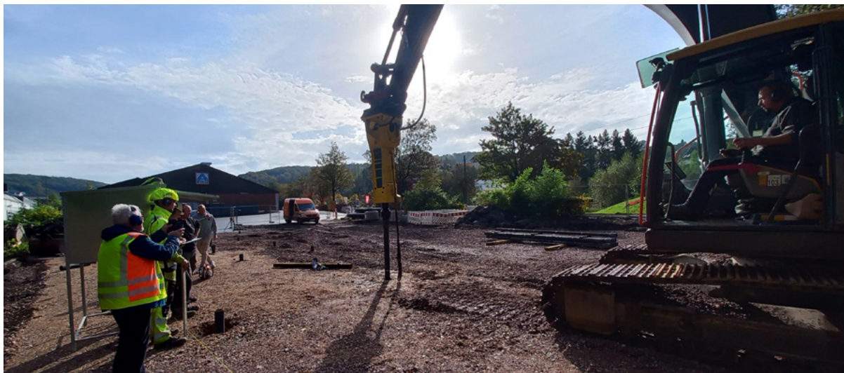
Pfahleinbringung unverpresster TRM Duktillrammpfähle in Anwesenheit des Tragwerkplaners
