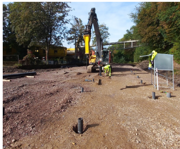
Pfahleinbringung unverpresster TRM Duktillrammpfähle in Anwesenheit des Tragwerkplaners
