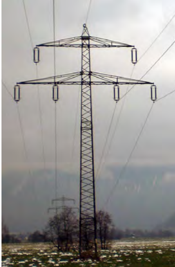
Schlanke Bauwerke mit besonderen Anforderungen an Fundierung und Windlasten
