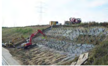
Böschungssicherung
