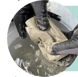
2. Anschließend wird das überschüssige Wasser leicht aus dem PrimaTape gedrückt.
