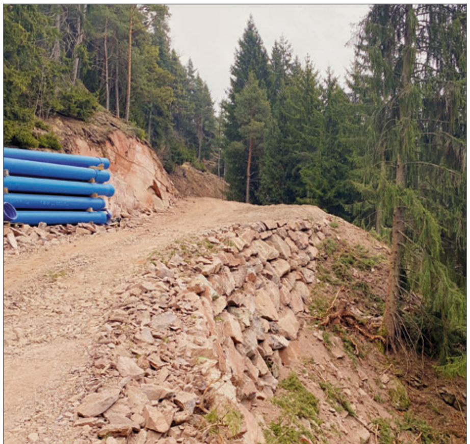
Abb. 7: Für die Zufahrtswege wurden ca. 10.000 m 3 Fels herausgesprengt und zahlreiche Stützmauern errichtet.
