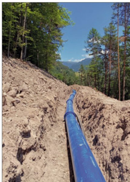
Abb. 4: Durch die Abwinkelbarkeit in den Rohrmuffen sind Kurven auch ohne Krümmer möglich. Das sparte Zeit und Geld in diesem schwierigen Gelände.
