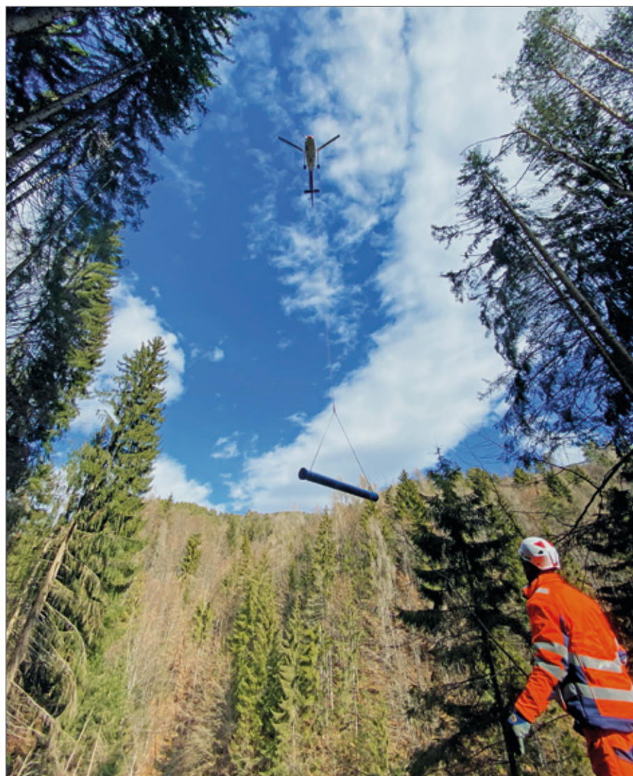
Abb. 9: Zu den am schwersten zugänglichen Bereichen der Rohrtrasse lieferte der Helikopter die Rohre.
