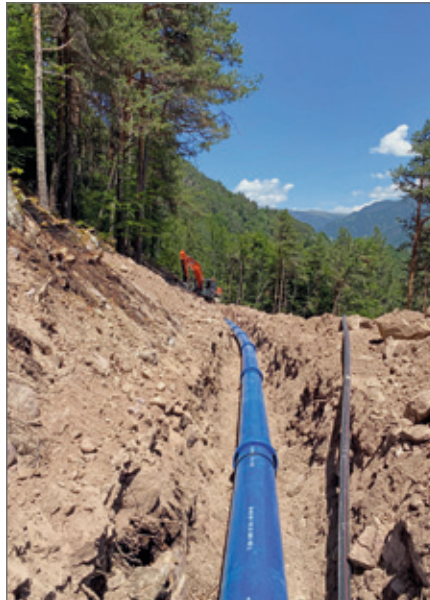
Abb. 2: Die Hauptleitung, bestehend aus Gussrohren der Tiroler Rohre GmbH, erstreckt sich auf über rund 30 km. Sie wurde komplett schub- und zuggesichert ausgeführt.
