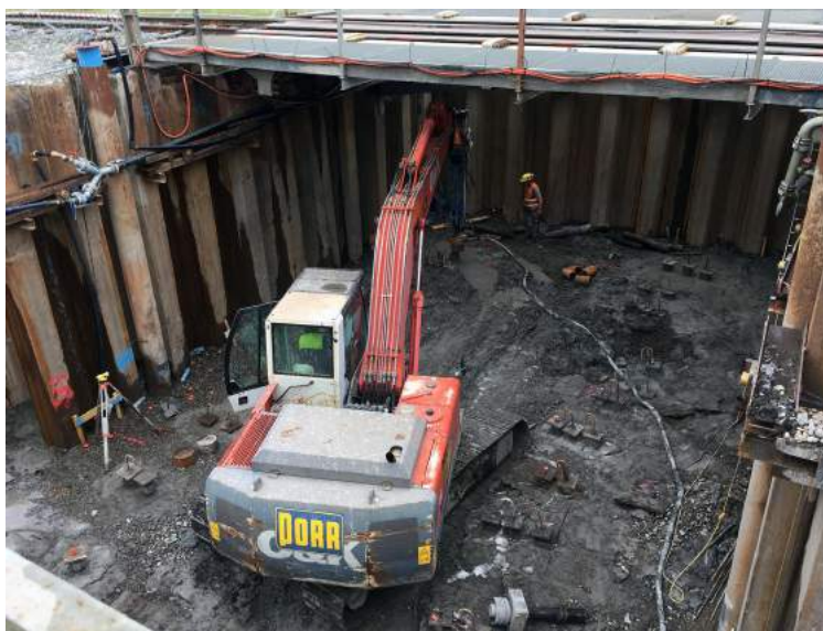
Ristrutturazione stazione ferroviaria Lustenau, Austria
