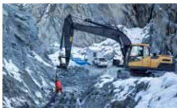
Condotte per innevamento e alta pressione
