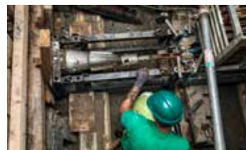
Metodo di posa senza scavo
