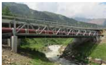
Tubazioni per il passaggio di ponti
