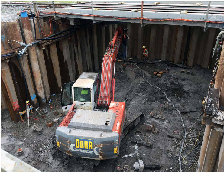
Bahnhof Lustenau, Österreich
