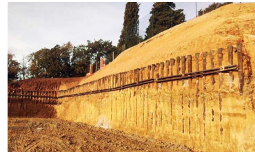
Baugrundsicherung in Fréjus, Frankreich
