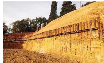
Stabilizzazione degli scavi a Fréjus, Francia
