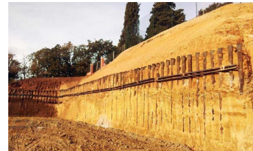
Baugrubensicherung in Fréjus, Frankreich
