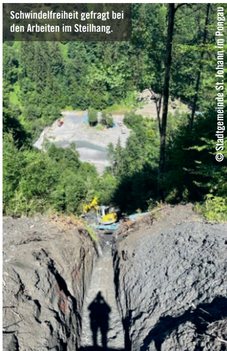
Bei der Neuaufschließung des Versorgungsgebiets müssen die Rohre bis zu 20 bar Druck standhalten, Gussrohre erfüllen diese Voraussetzung vollumfänglich.
